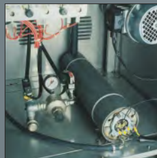
» ΜΟΝΩΣΗ BOILER INOX AISI316
